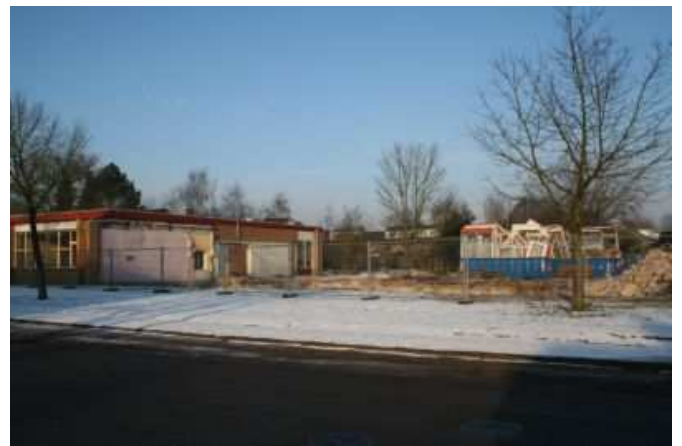
6/1/2009: fundering er ook uitgetrokken, pui in de containers, puin schiften is aan de gang (rechts)
