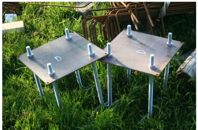
20/05: Draadlengtes voor inbedding in beton, voor de volgende fase neem ik aan....
