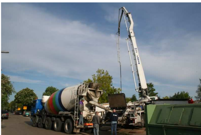
19/05: betonauto met betonspuit
