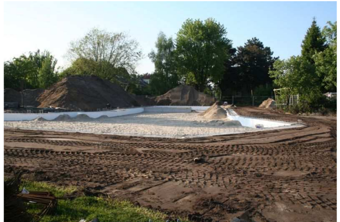
20/05 na het beton is uitgehard wordt de aarde weer aangevuld aan de buitenkant van de fundering
