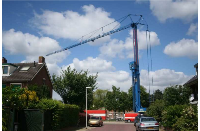
15/06: een mobiele torenkraan tilt in een dag alle kalkzandsteen op de groffe plek waar het hoort te komen
