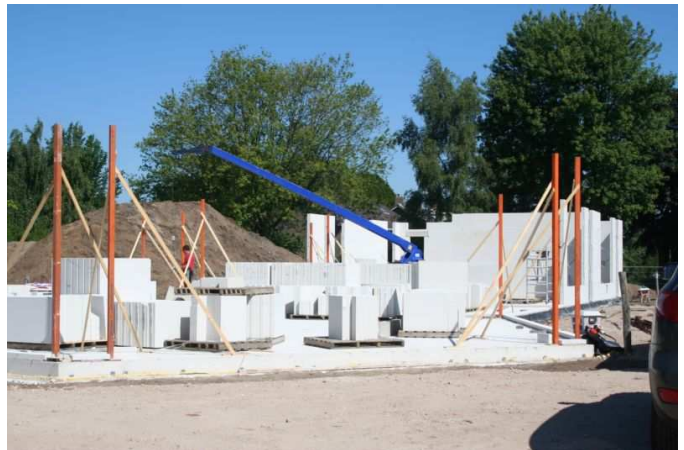
17/06 De kalkzandsteen staat op de pallets op de groffe plek van bestemming. Vandaar af wordt ieder blok nu door een stelkraan (de blauwe op de foto) als een puzzelstukje op z'n uiteindelijke plek gezet en met lijm verbonden met de andere blokken: Lijmen van de binnenmuren. Het eerste resultaat is al zichtbaar in de vorm van de kozijnopeningen van 2 kleuterklassen en een deuropening aan de pleinzijde van het pand.
