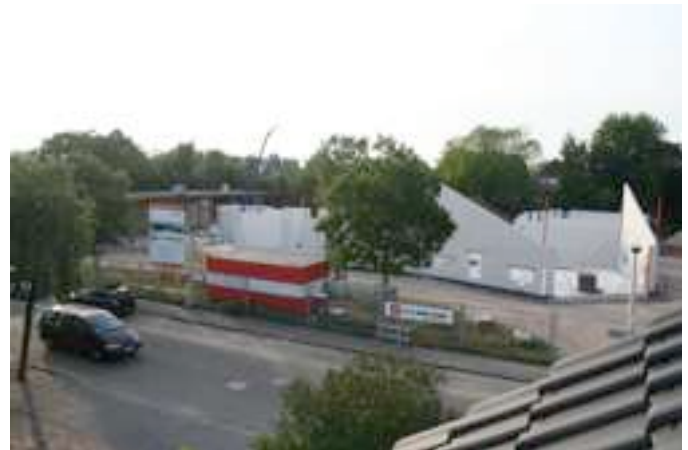
Overzicht van de bouwplaats 24/06
