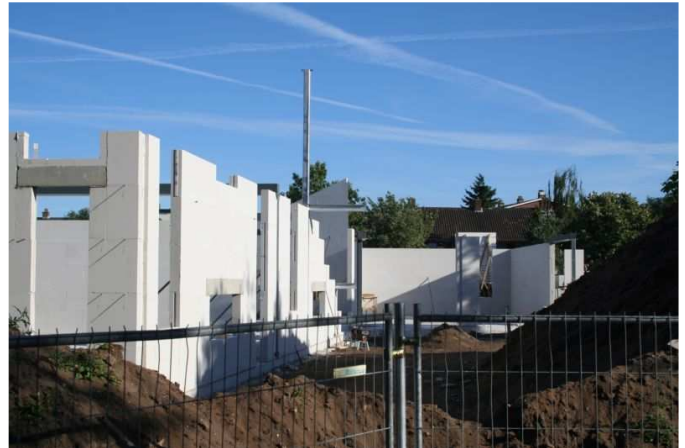
Weer iets verder kijken we op de 'ingang' van de school. We moeten om hoge bulten aarde heen, de rest van de muren is van achter het hek niet te zien. De stalen pilaren met uitkraag zijn voor de (deels) buitenliggende trappen.
