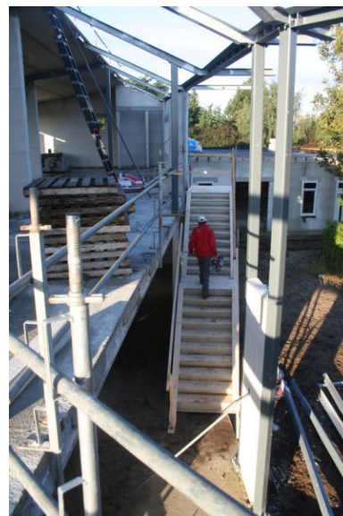
Goed is de uitkragende trap te zien. Hij begint onder 'in' het gebouw en eindigt boven 'buiten' het gebouw.
