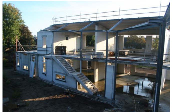
De 'kleine' vleugel, nu nog zonder 10 e lokaal, wel met trap en betonnen dak.
