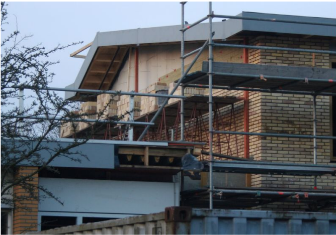
Foto 2: het laatste stuk metselwerk wordt nu afgemaakt.
