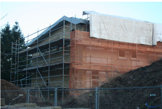
Foto 3: extra zeilen over de dakrand. Tegen de regen neem ik aan?
