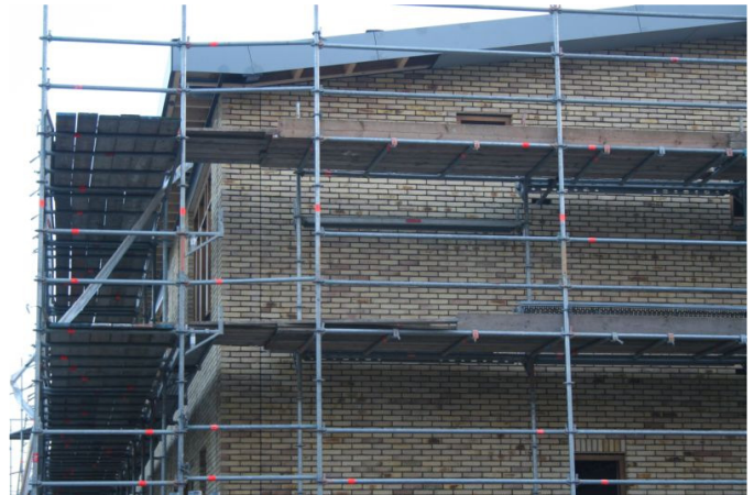
Foto 4: Moeilijk te zien, maar deze muur is geheel gevoegd, de afwerking van de overstek wordt nu gedaan.
