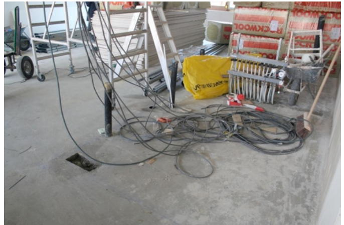
Kabeltjes trekken... allemaal IT
