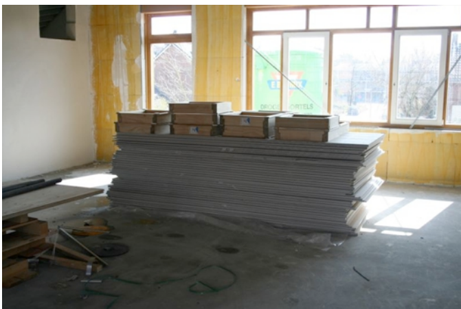
Gipsplaten worden naar binnen gebracht.
