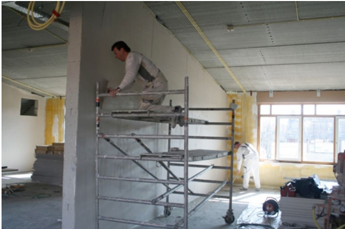
Stucadoors aan het werk
