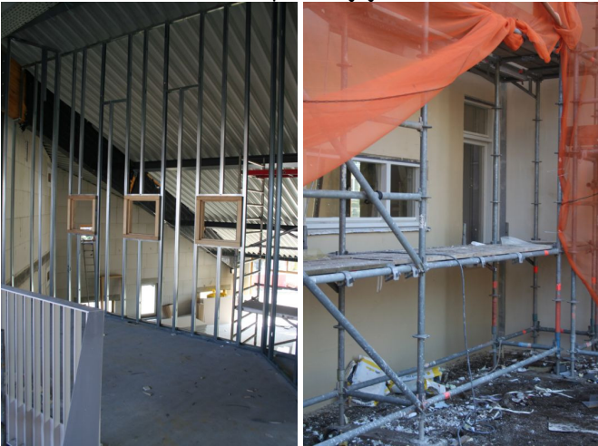
Links: En de laatste keer dat ik van bovenaf zo de grote zaal in kan kijken. Straks zijn er nog 3 raampjes over ☺ Rechts: buiten wordt ook gestuud om de muren tegelklaar te krijgen.
