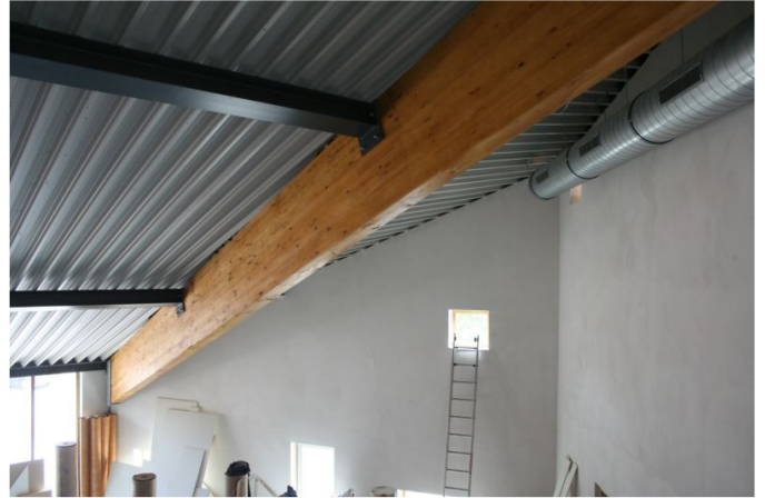
Plastic om de houten balk vandaan
