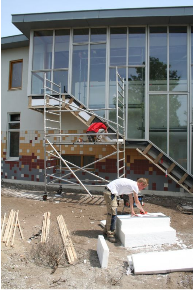
Afwerking aan de buitenkant: beton weg!
