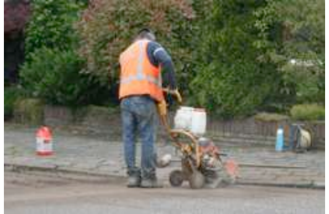
De voedingskabel moet naar een onderstation, volgens mij ergens langs de A1. Eerst wordt het asfalt gesneden, komt er een mantelpijp in de grond, wordt de straat weer gemaakt en kan de kabel erdoorheen getrokken worden. Dat trekken gebeurt met een minikraantje.. Vervolgens gaan ze stukje bij beetje de kabel ingraven onder de stoep.
