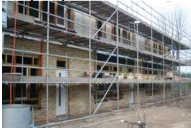
Boven hangen nu ook de meeste kozijnen en het metselen op hoogte is begonnen.
