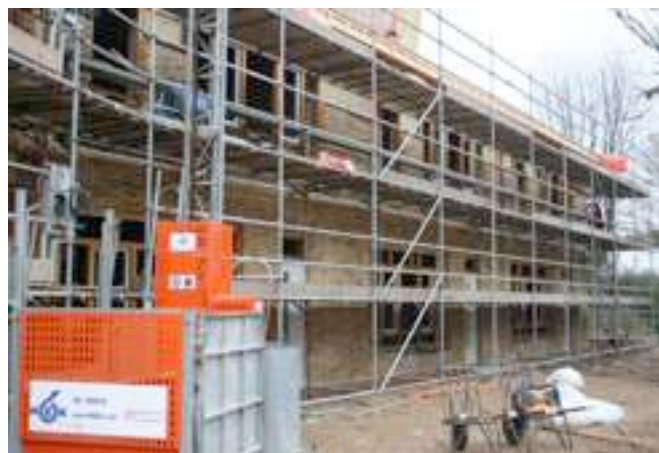
Zijmuur Cornelia de Langelaan, metselwerk bijna boven.
