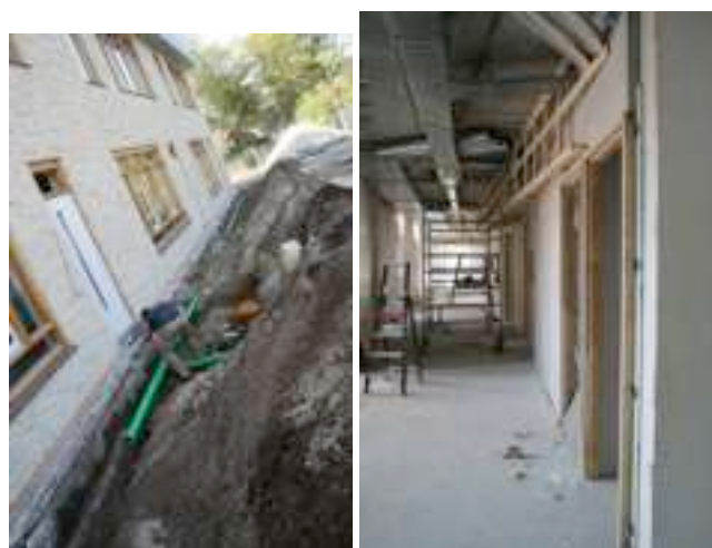
Links: Hemelwaterafvoer aansluiten op de 'plastic dozen' die nu ingegraven zijn. Rechts: Plafondafwerking in de gang begint vorm te krijgen. Mooi om de rechte lijn van het houtwerk te zien tegen de inspringende wanden van de lokalen
