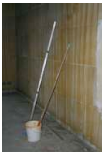
De stucadoor is boven aan het voorstrijken geweest.
