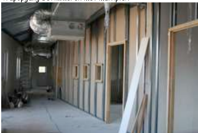
Met gipsplaten 1 zijde van de metalen frames afgeschroefd
