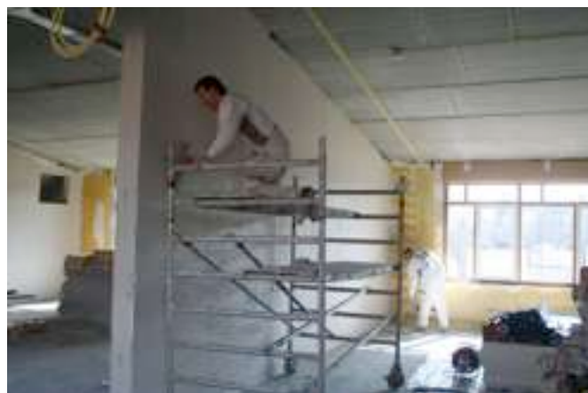
Stucadoors aan het werk
