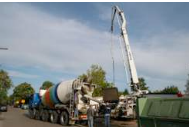
19/05: betonauto met betonspuit
