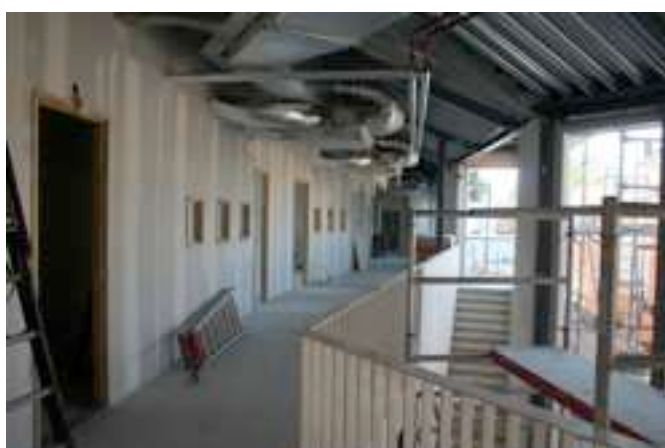
En de 'hal boven'. Achter is de liftdeur te zien. De lift is geïnstalleerd.
