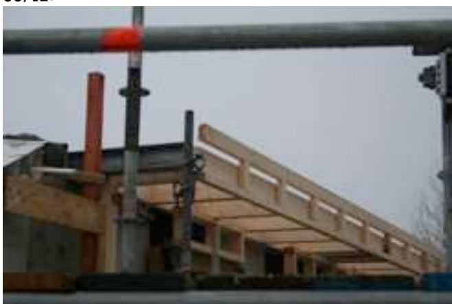
Overstek basisconstructie
