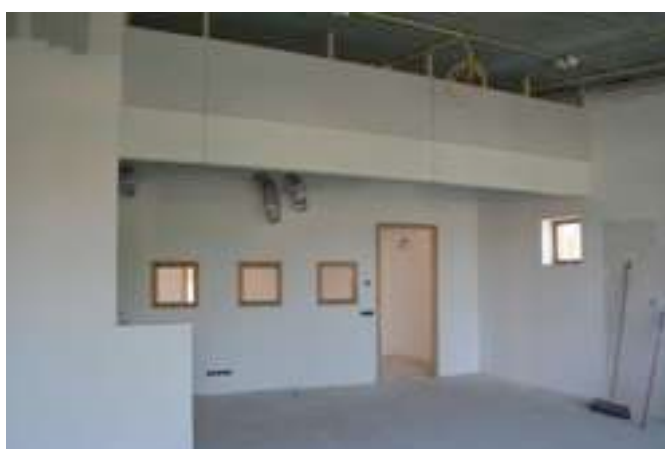
De binnenkant van het 'tiende lokaal' begint vorm te krijgen. Latexen is gestart evenals het 'valse plafond' boven het ingangs- en keukengedeelte.
