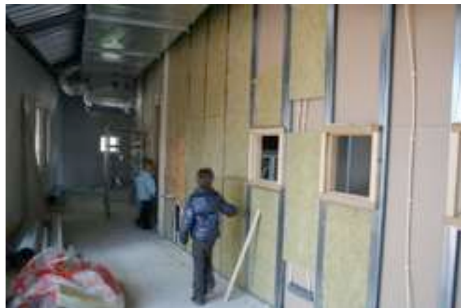
Yoram en Thijmen inspecteren de isolatie voordat de tweede gipslaag er op gaat.
