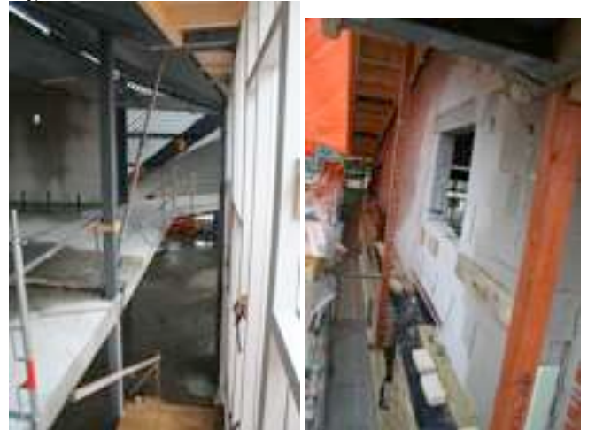
Trapopgang en buitenmuur met opgaand metselwerk
