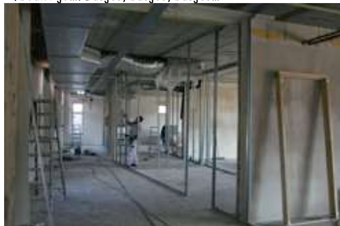
Metalen frames plaatsen
