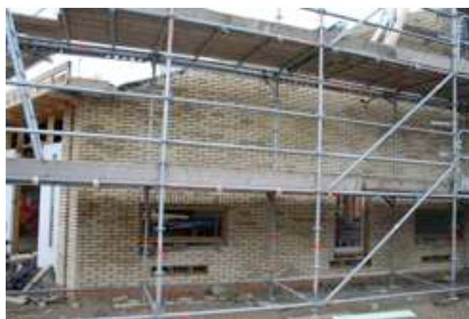
Dit stukje muur klaar, nu nog voegen....
