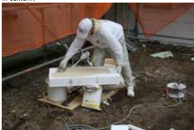
Aan de pleinzijde is men begonnen met het beplakken van de gevel met isolatiemateriaal waarop weer de tegelmuur kan komen.
