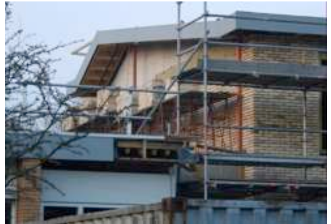
Foto 2: het laatste stuk metselwerk wordt nu afgemaakt.
