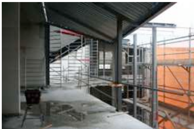
Zicht naar de 'brug' De steigers zijn met netten omspannen om regen en 'troep' zoveel mogelijk tegen te houden.
