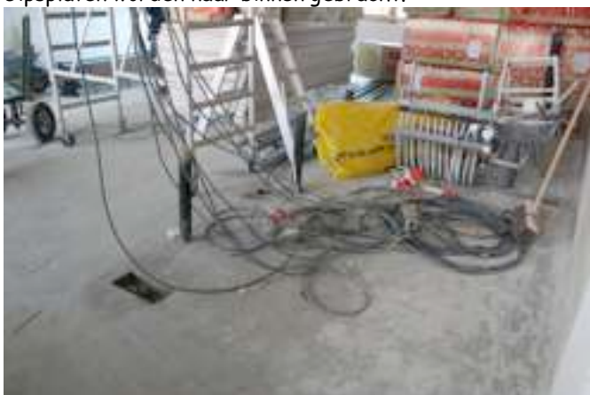
Kabeltjes trekken... allemaal IT
