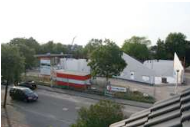
Overzicht van de bouwplaats 24/06
