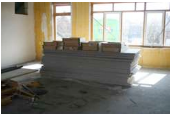
Gipsplaten worden naar binnen gebracht.
