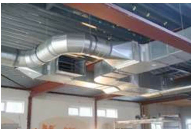
De eerste luchtbehandelingspijpen zijn opgehangen. Het betere lego-werk
