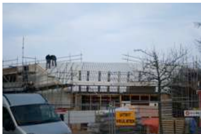
Het kanaaldak is klaar. Voorbereidingen voor de verdere afwerking worden getroffen.
