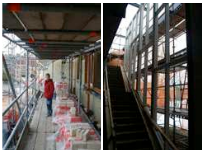
Opzichter Thijmen op de steiger met de stenen en rechts het trappenhuis met het houtskelet voor de ramen bijna klaar
