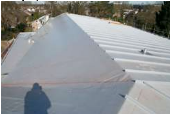
Op het nieuwe dak. Het dak is dicht, de lamellen zijn puur voor de esthetiek heb ik van de dakdekkers begrepen. Het staat ook zo op tekening. Alles kunststof by the way.
